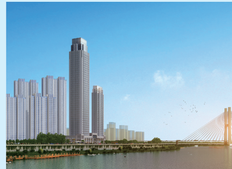
盛达公馆（超高层建筑）
