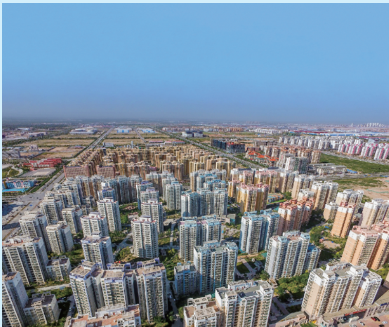
兰州新区保障性住房建设项目
