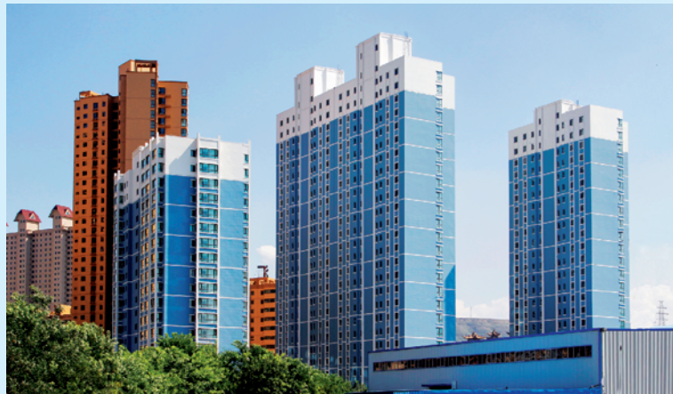
兰州理工大学教职工住宅楼（甘肃省建设工程“飞天奖”）
